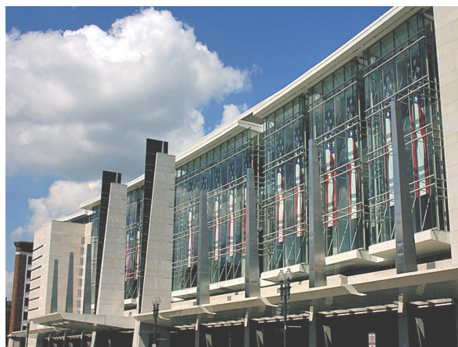
位于华盛顿特区的华盛顿会议中心使用了PPG Sungate 100低辐射镀膜玻璃
